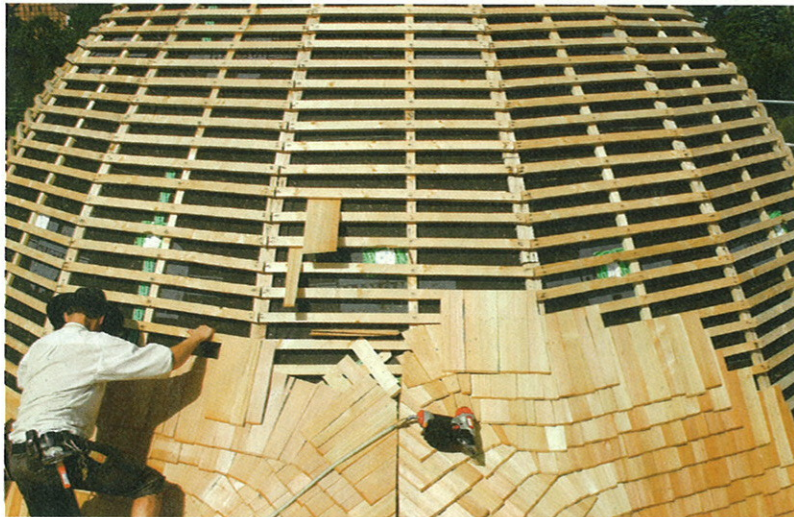
Die Kuppel erhält eine Eindeckung aus Lärchenholzschindeln
