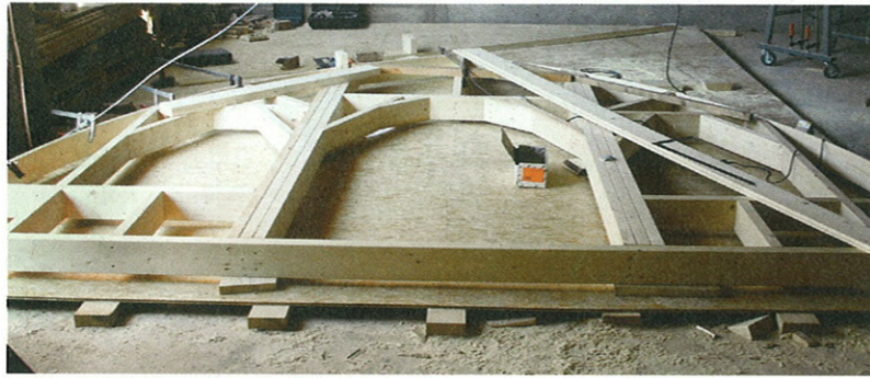
Das Eingangselement wird auf dem Schnürboden der Zimmerei abgebunden
